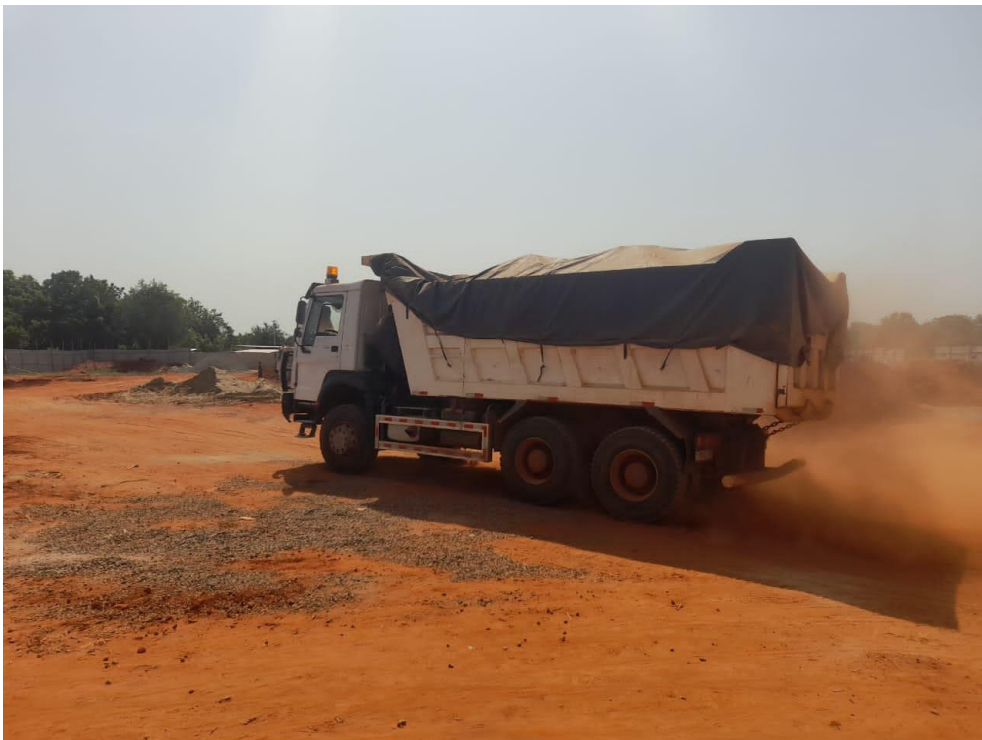
Camion d'approvisionnement en remblai bien bâché
