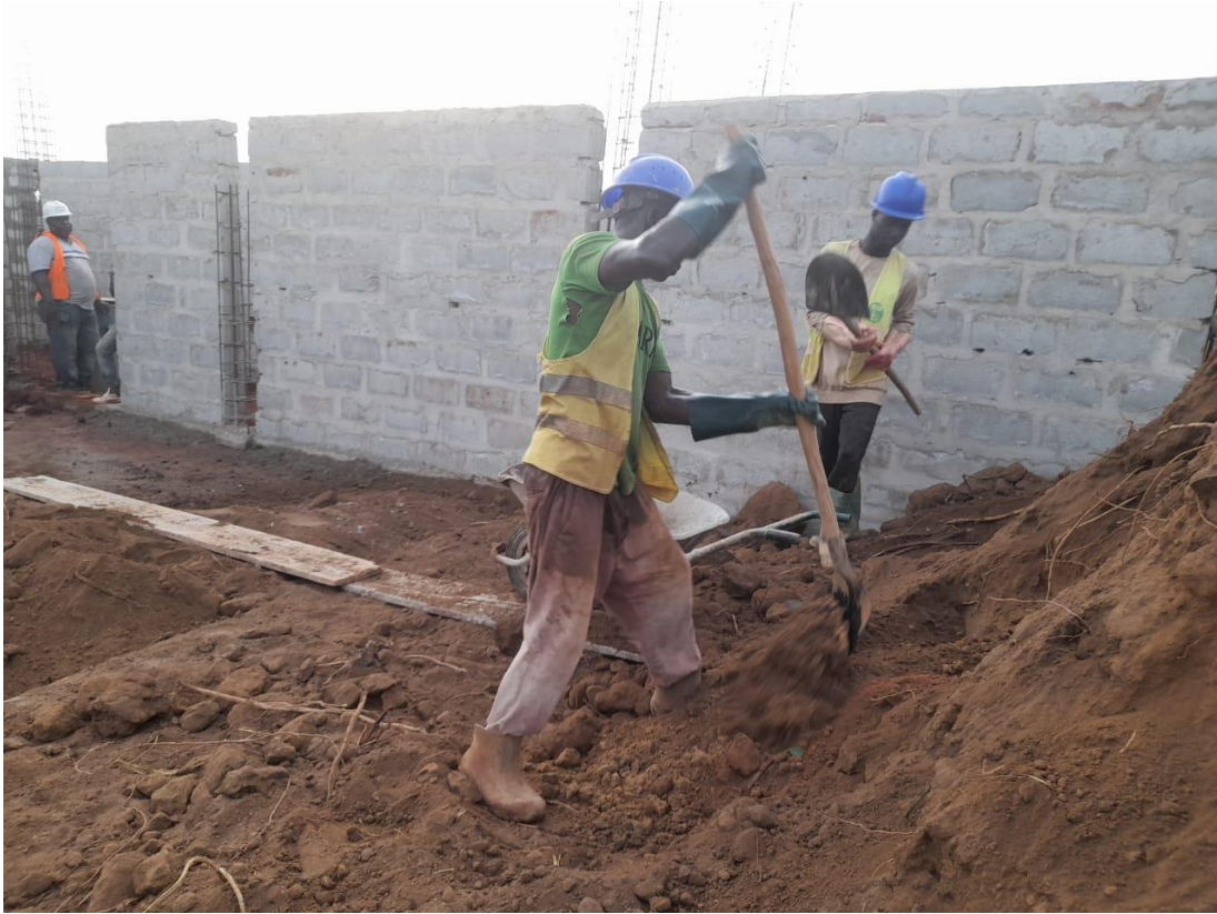
Ouvriers réalisant le remblai
