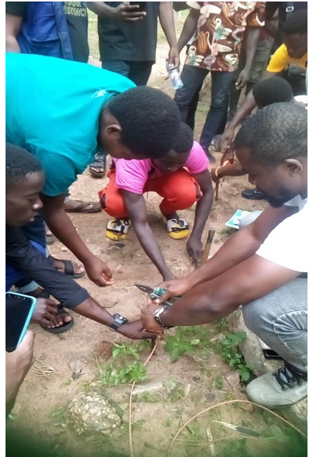
Photo4 : Réalisation des piquets de terre sur chantier
