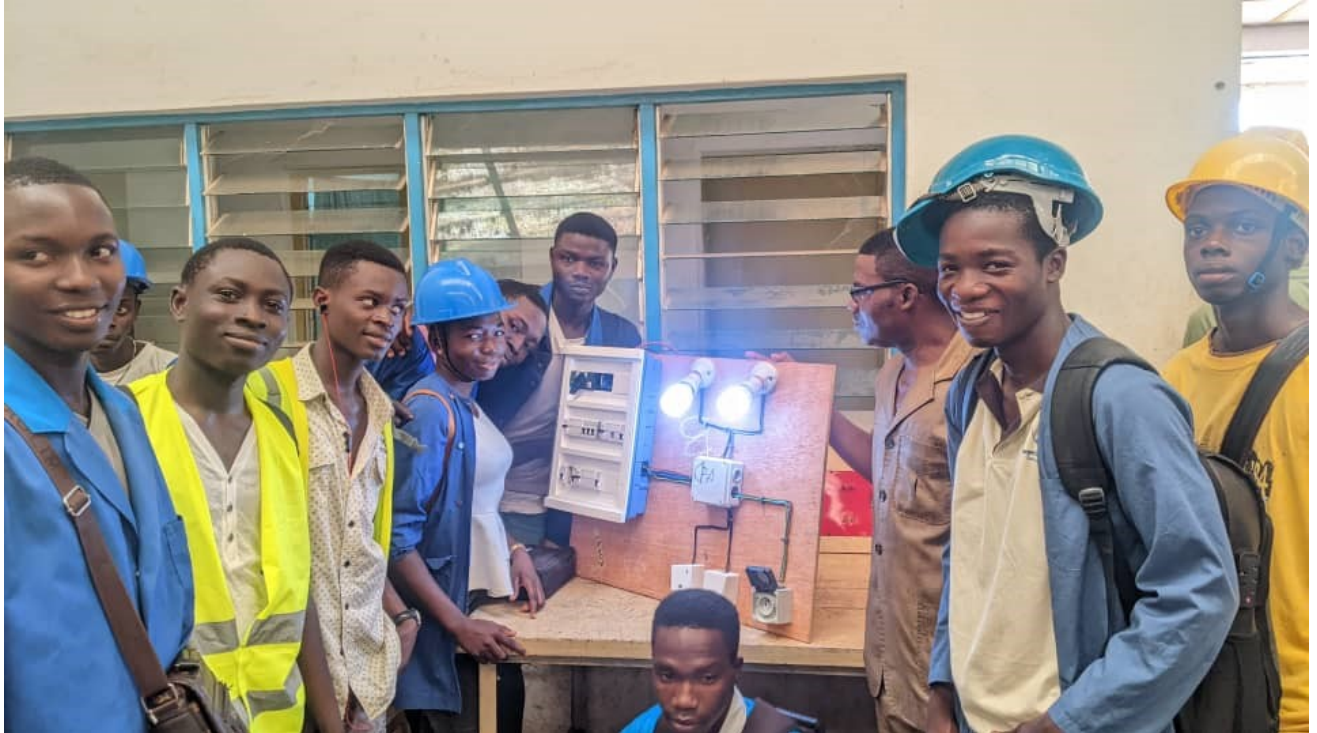
Photo : câblage des coffrets électrique bâtiment
