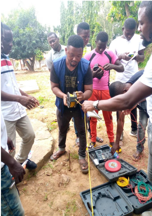
Photo4 : Réalisation des piquets de terre sur chantier
