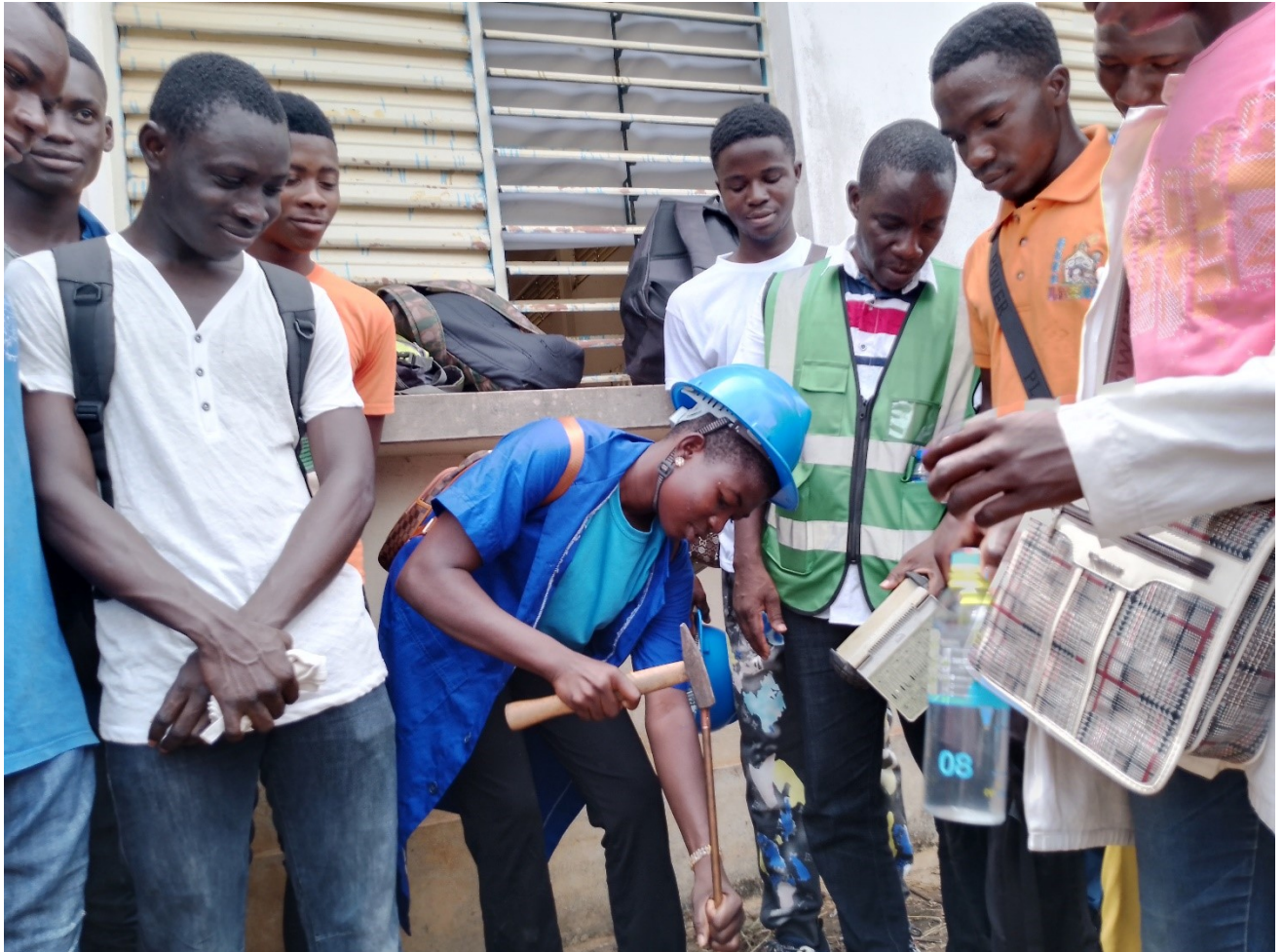
Photo : Réalisation des piquets de terre sur chantier
